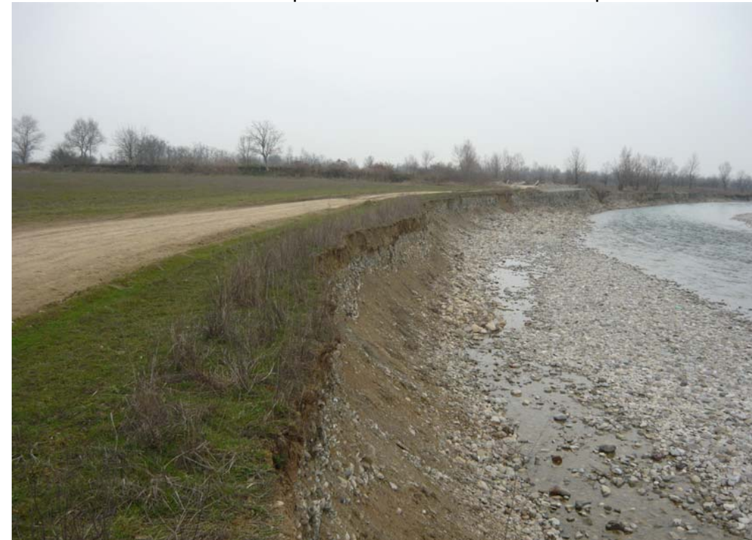
FOTO 4: Intensa erosione di sponda in località C.na della Volpe
