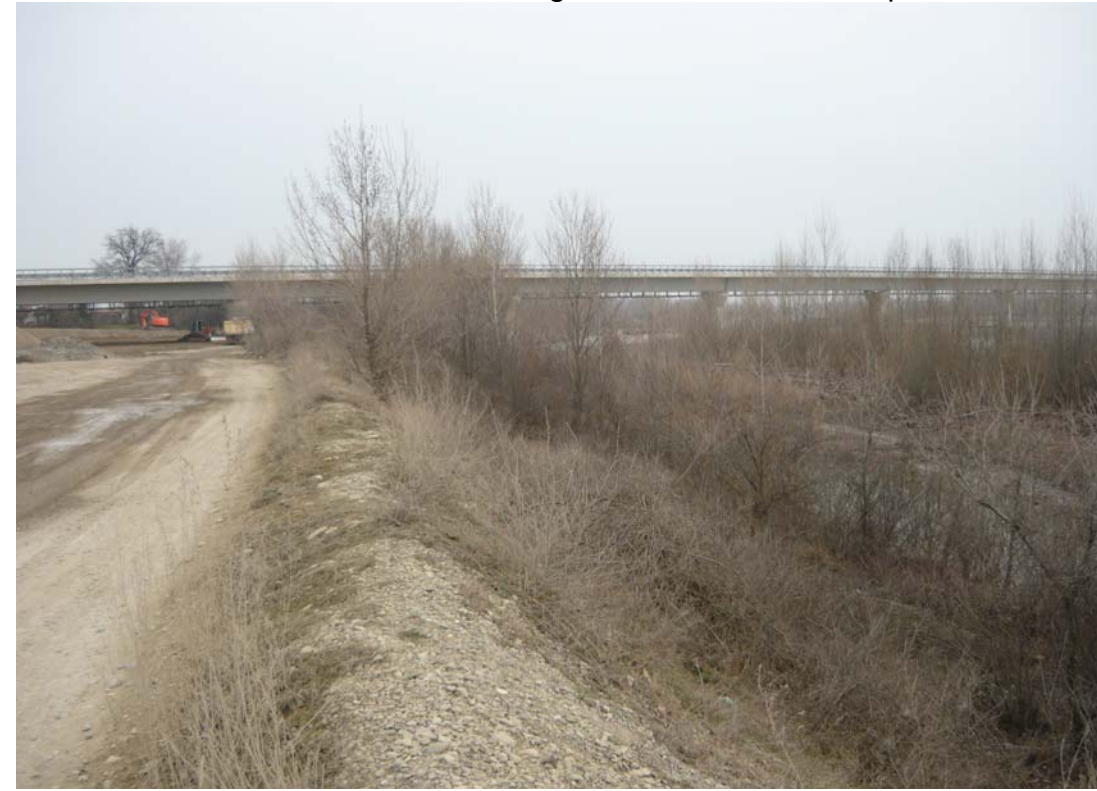
FOTO 2: Ponte nuovo in località Mamago : vista della linea di sponda sx da monte
